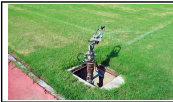
[NO] 스프링클러 시설이 코너아크에 너무 근접해 있어 안전상의 문제 발생(안전 미확보)
