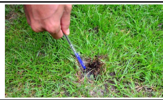
[YES] 스프링클러 헤드가 보이지 않게 설치(안전 확보)
