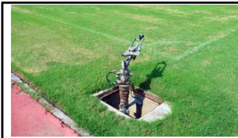
[NO] 스프링클러 시설이 코너마크에 너무 근접해 있어 안전상의 문제 발생(안전 미확보)
