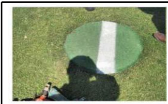
[NO] 피치 위에 부적합한 스프링클러 커버 설치(안전 미확보)
