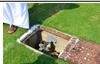
[NO] 관개 시설 메탈 커버가 터치라인과 겹쳐있음(안전 미확보)
