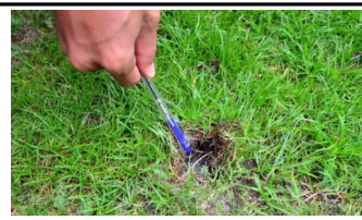
[YES] 스프링클러 헤드가 보이지 않게 설치(안전 확보)
